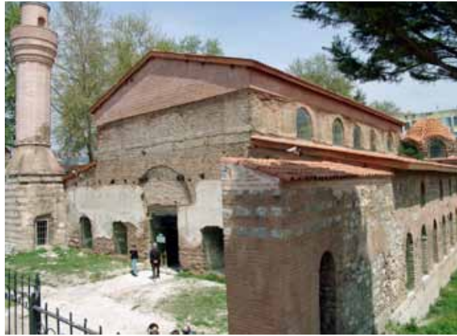
Ayasofya, onarımdan sonra.
